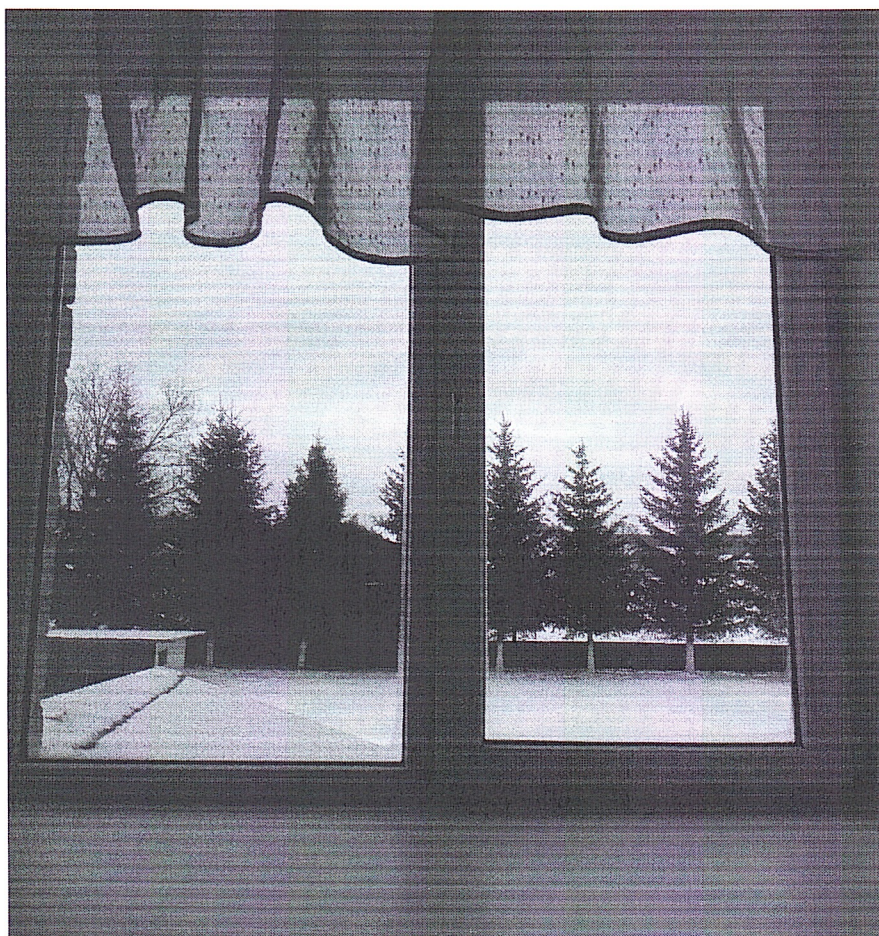
Фото окон с установленными замками в коридорах
