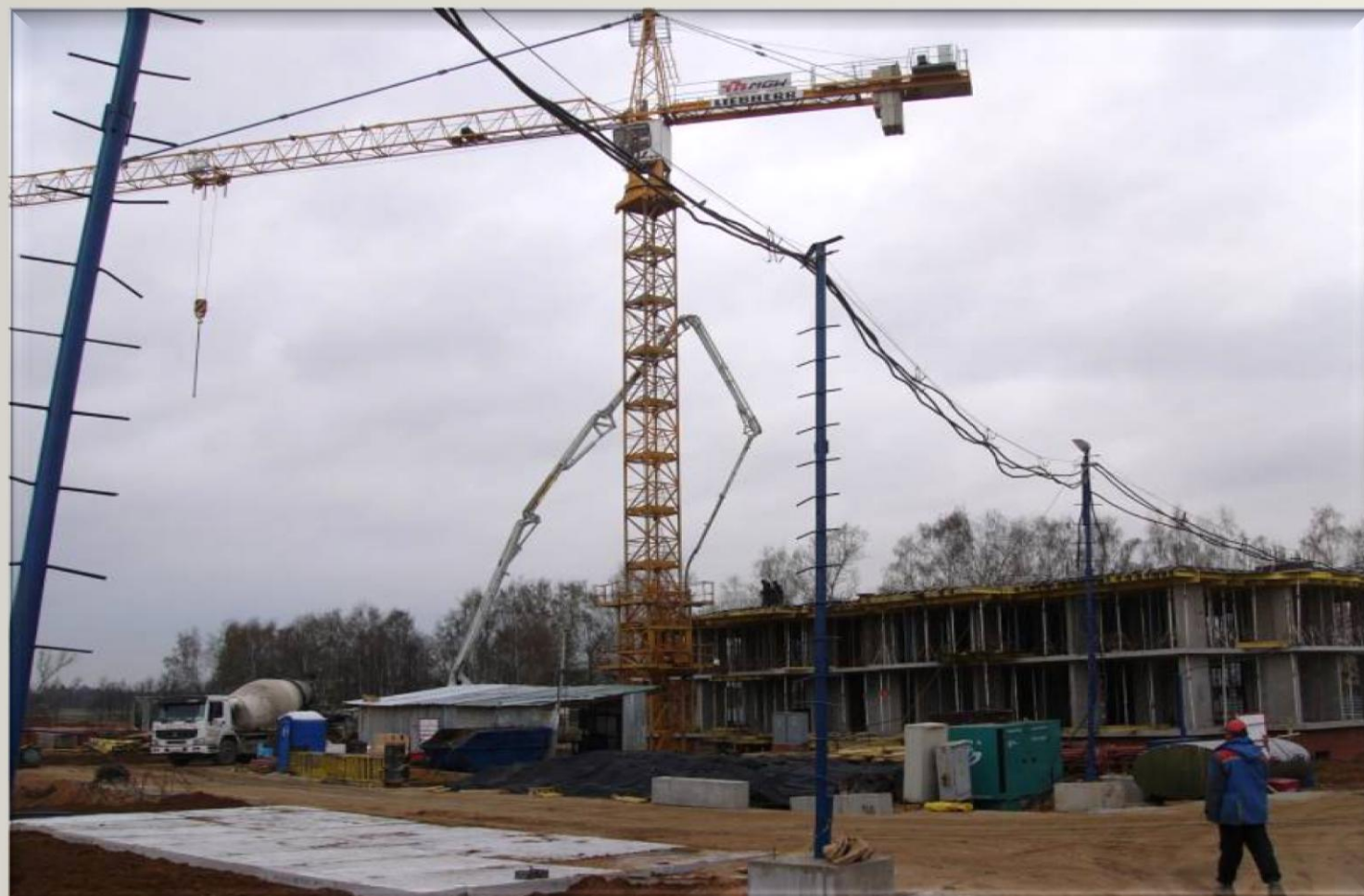
Строительство новых микрорайонов в городе Пушкино
